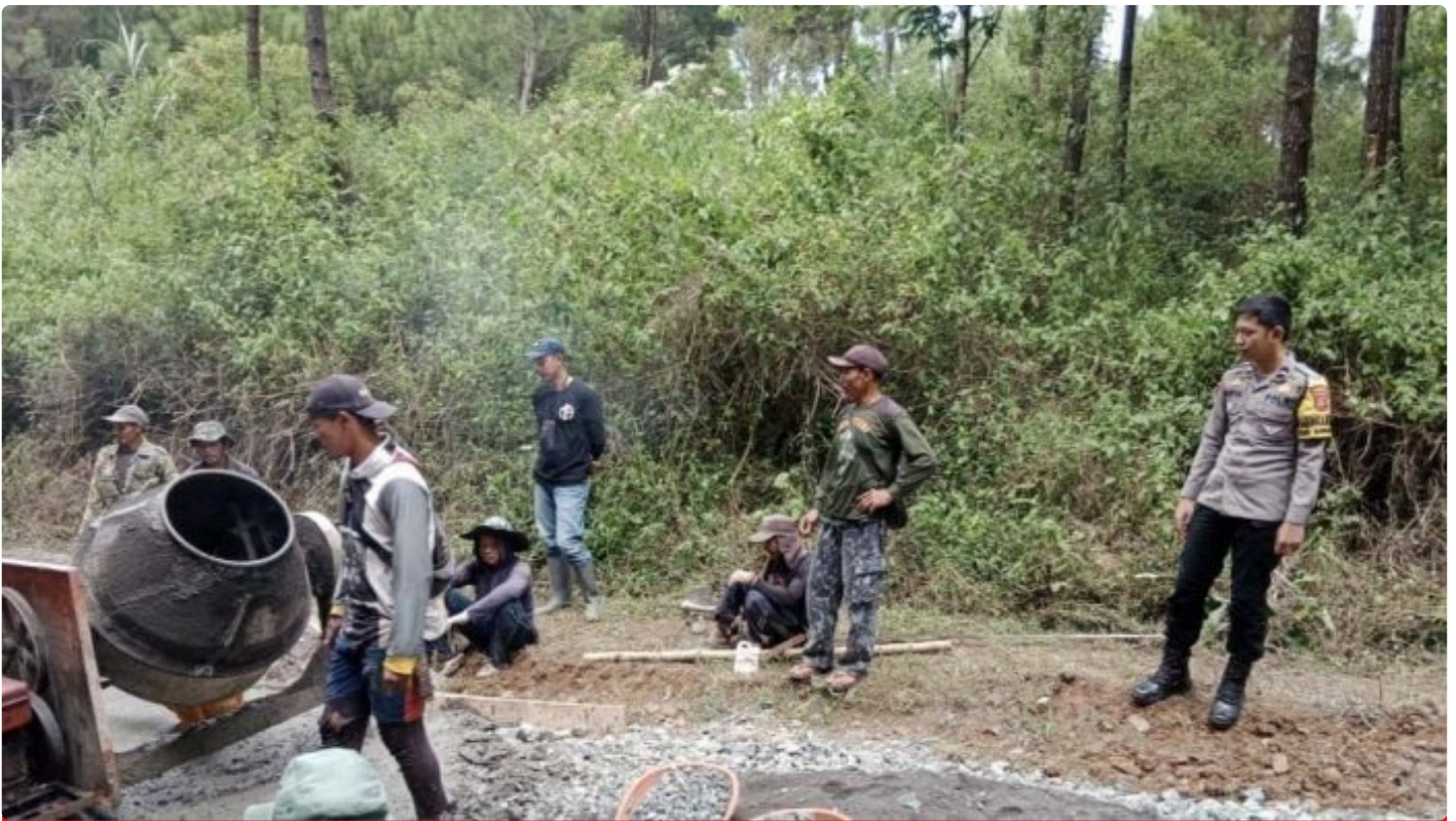
Polsek Jampang Tengah Polres Sukabumi Monitoring Pembangunan Jalan Desa
