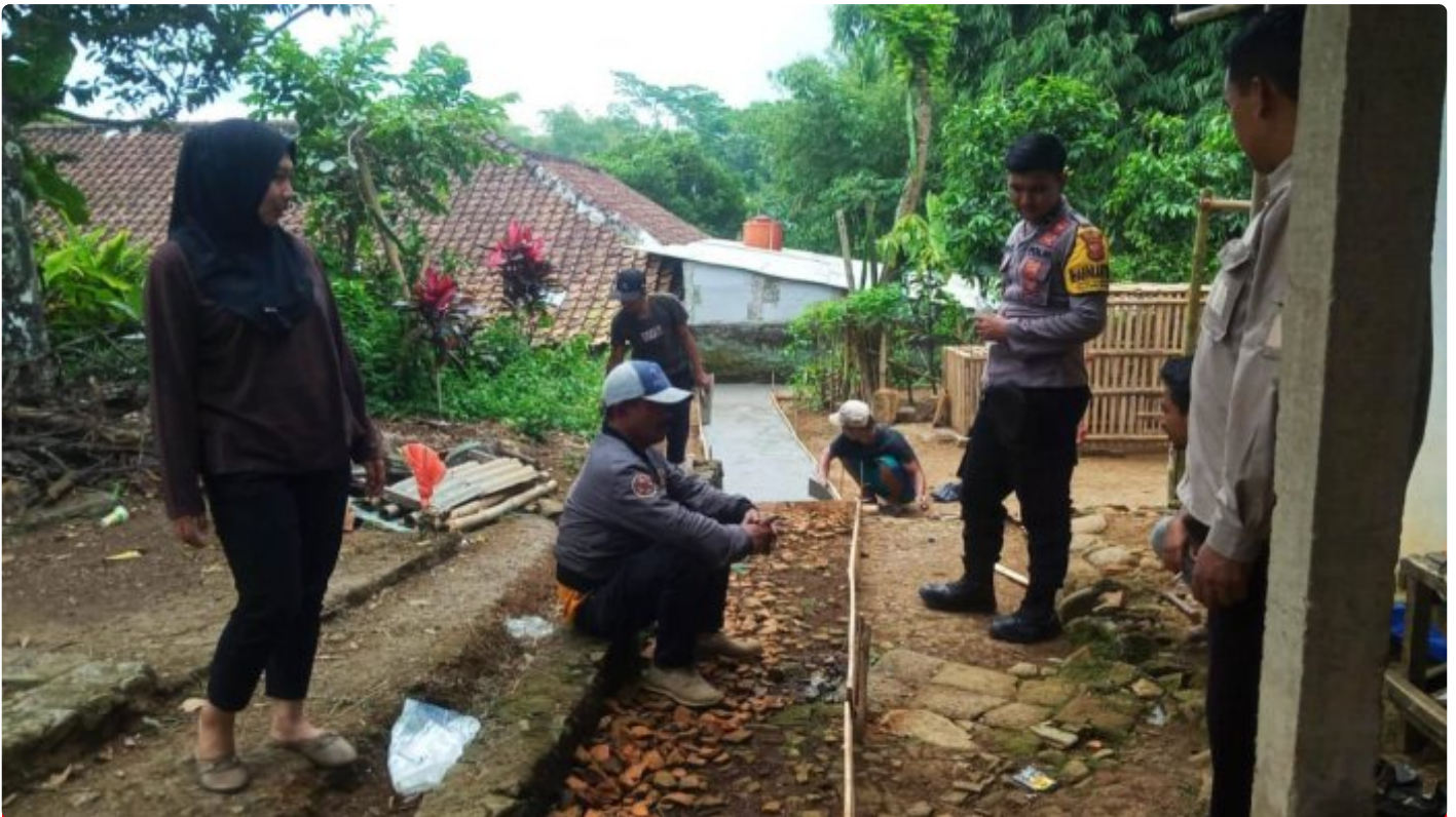
Bripda M. Reza Rizaldi Ajak Warga Kp. Pareang Gotong Royong dalam Rehabilitasi Jalan Lingkungan
