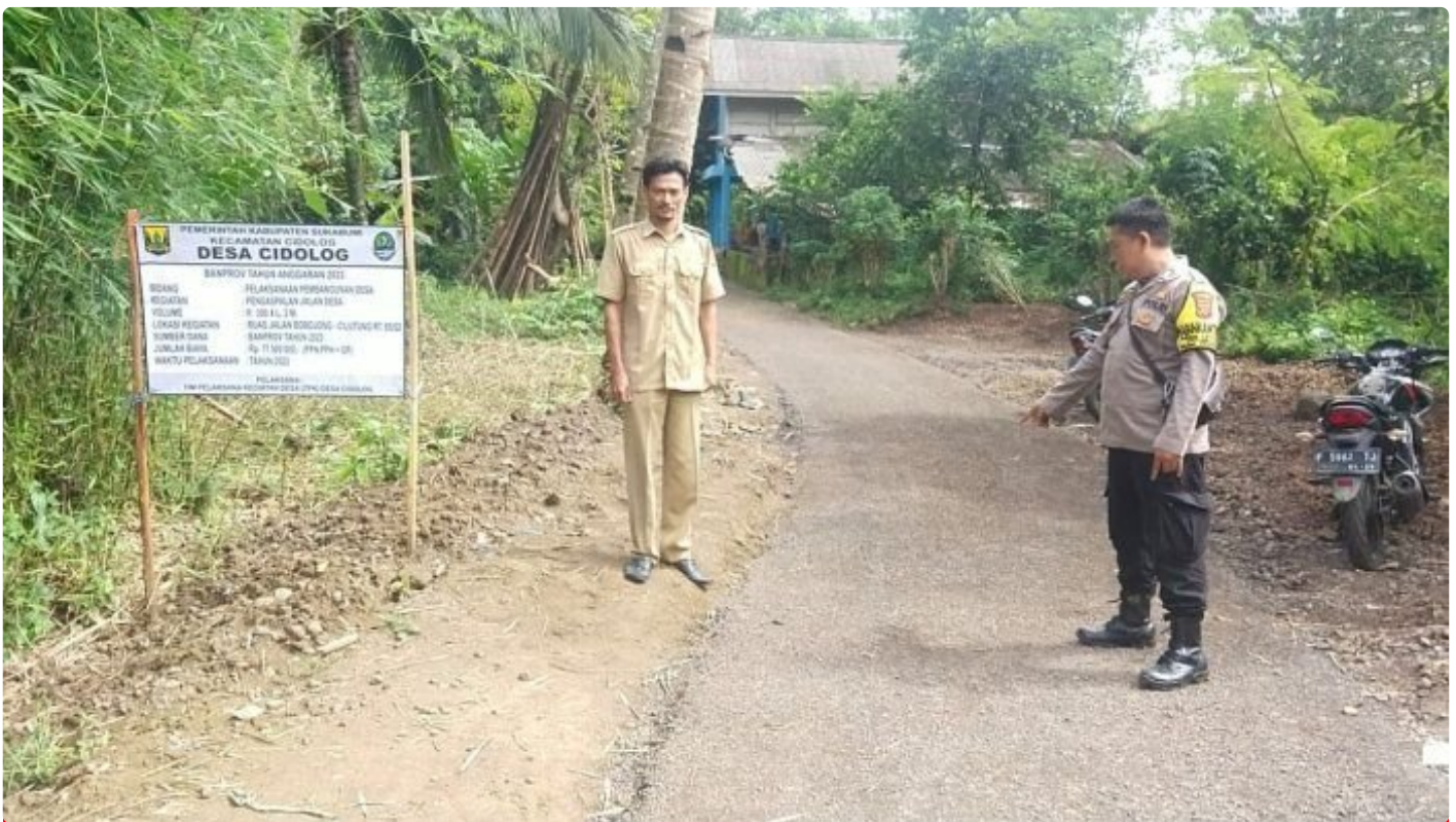
Bhabinkamtibmas Desa Cidolog Awasi Pembangunan Desa
