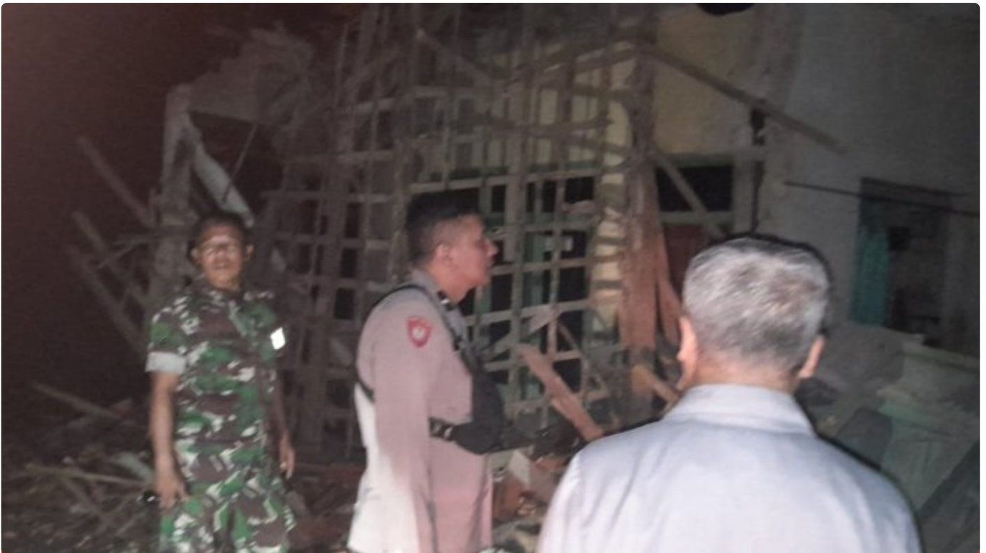
Bangunan Rumah Ambruk di Wilayah Hukum Polsek Surade Polres Sukabumi Desa Cidahu Akibat Gempa, Tidak Ada Korban Jiwa
