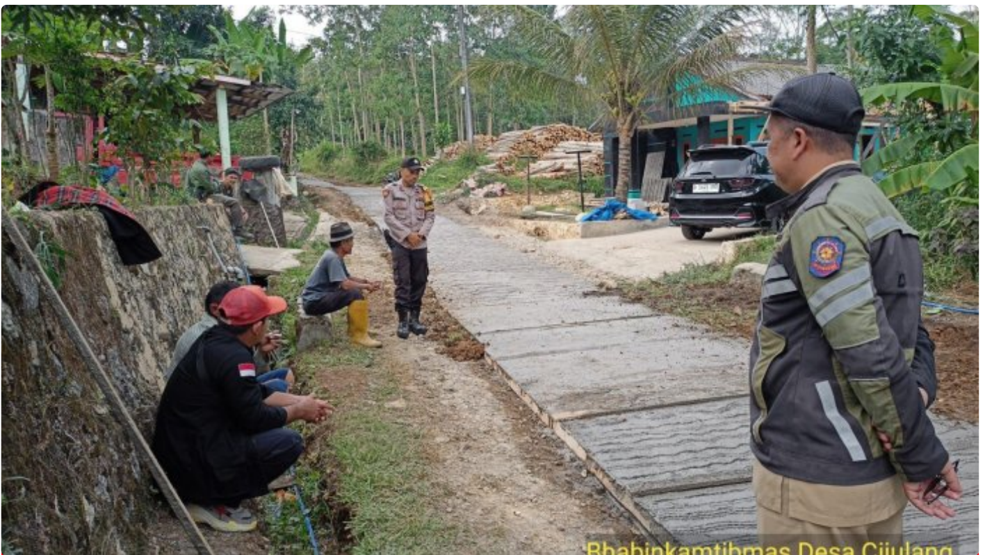
Aipda Sudiro Monitoring Pembangunan MCK di Desa
